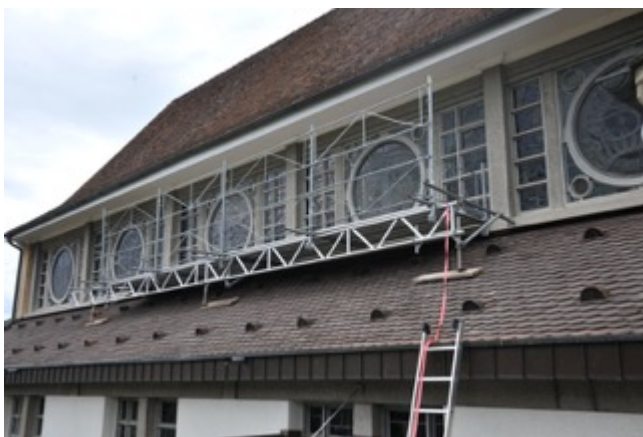
Fig. 23 : Échafaudage monté sur la façade sud à Courfayvre.
