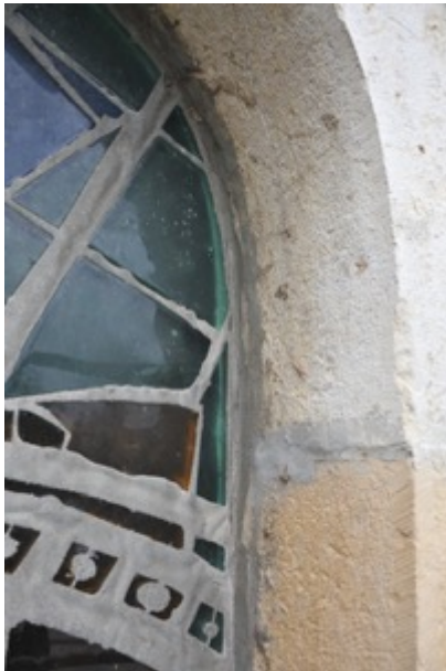
Fig. 21 : Détail du montage au mortier.
