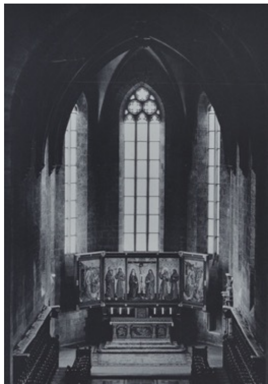
Fig. 5 : Vue du chœur de l'église après la dépose des vitraux (avant le montage des rideaux). La photo montre le nouveau remplage de la fenêtre centrale.
