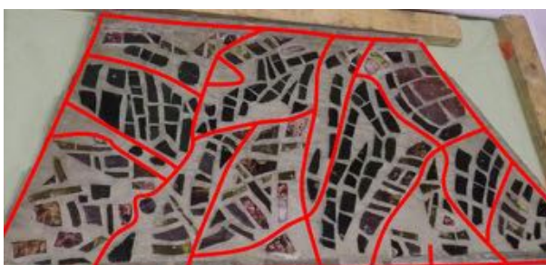
Abbildung 55: Fribourg, Fensterteil 3c, Bewehrung gemäss Magnet
