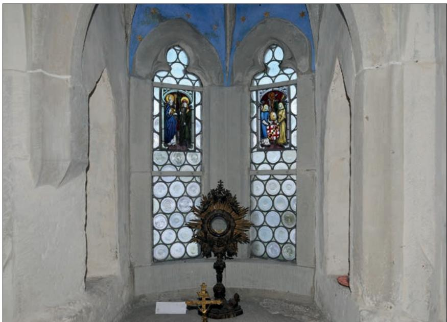
Fig. 2. Vitreries à cives avec vitraux intégrés, placées directement dans la feuillure de fenêtre ; sans vitrage de protection.
