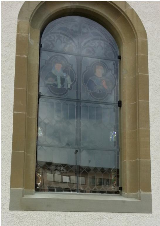
*Abb. 5: Rahmenlos angebrachte, einfache vorgesetzte Aussenschutzverglasung, Katholische Kirche in Marly (Konzept und Ausführung Daniel Stettler, Bern, 2012).*
