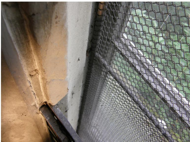
*Abb. 23: Blick in den Zwischenraum zwischen Glasmalerei (Kante eines Feldes links unten) und vorgesetzter Aussenschutzverglasung im Chorfenster.*
