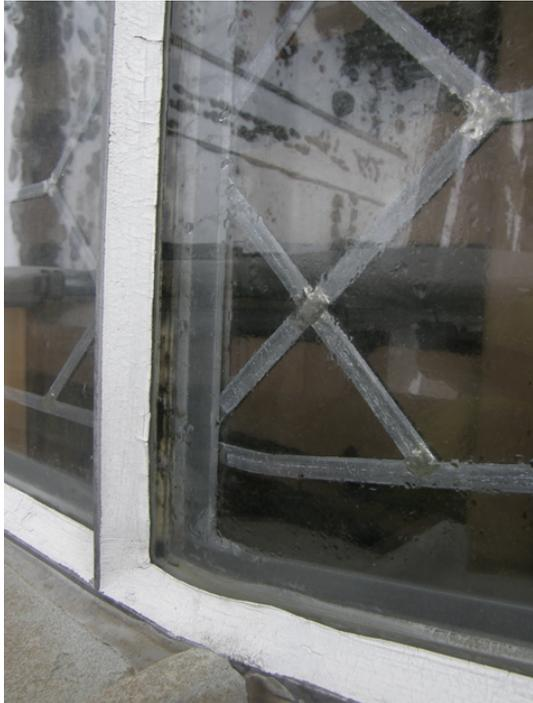
*Abb. 12: Aussenschutzverglasungen im Verbundsystem (mit Einfachverglasung). Schutzverglasung von ca. 1970, Kirche Märwil (AG).*
