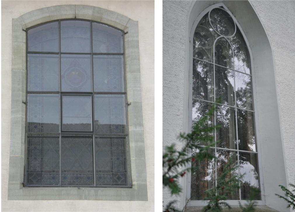
*Abb. 4: Einfache vorgesetzte Aussenschutzverglasungen
