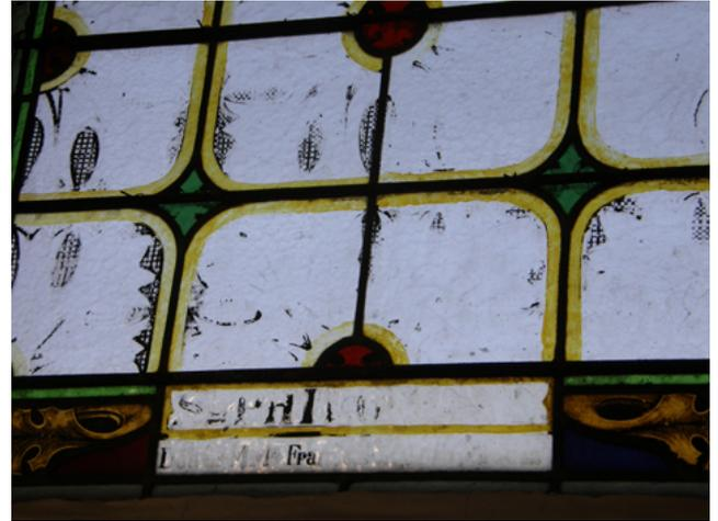
*Abb. 7: Bild links: Unversehrte Glasmalereien in der Kirche in Vuisternens-devant-Romont (Kirsch und Fleckner 1910); Bild rechts: Geschädigte Glasmalereien in der Kirche von Villaraboud mit deutlichen Schwarzlotablösungen (Kirsch und Fleckner 1911).*
