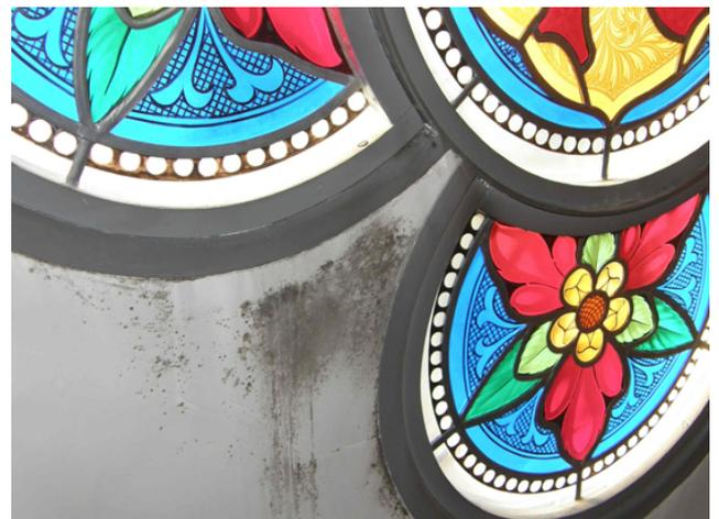
*Abb. 13: Aussenschutzverglasungen im Verbundsystem mit Isolierverglasung. Bild links: Aussenansicht eines Fensters der Kirche in Rüti; Bild rechts: Innenansicht desselben Fensters mit Schimmelpilzbefall auf der das Fenster umgebenden Wandfläche.*
