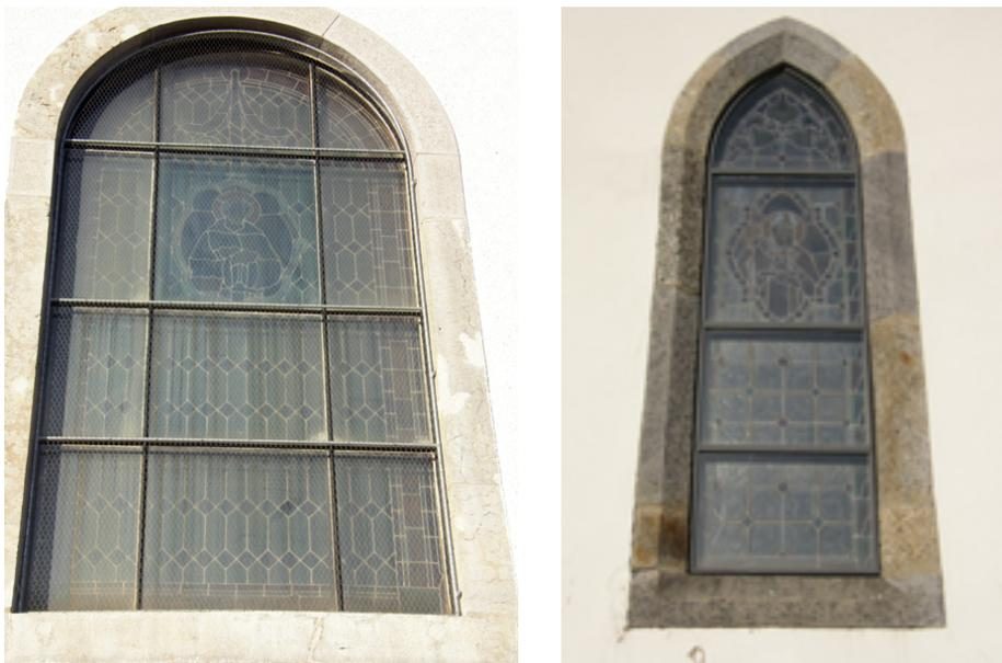
*Abb. 6: . Bild links: Aussenschutzverglasung an der Kirche in Vuisternens-devant-Romont (ca. 1910); Bild rechts: Aussenschutzverglasung an der Kirche von Villaraboud (ca. 1990).*
