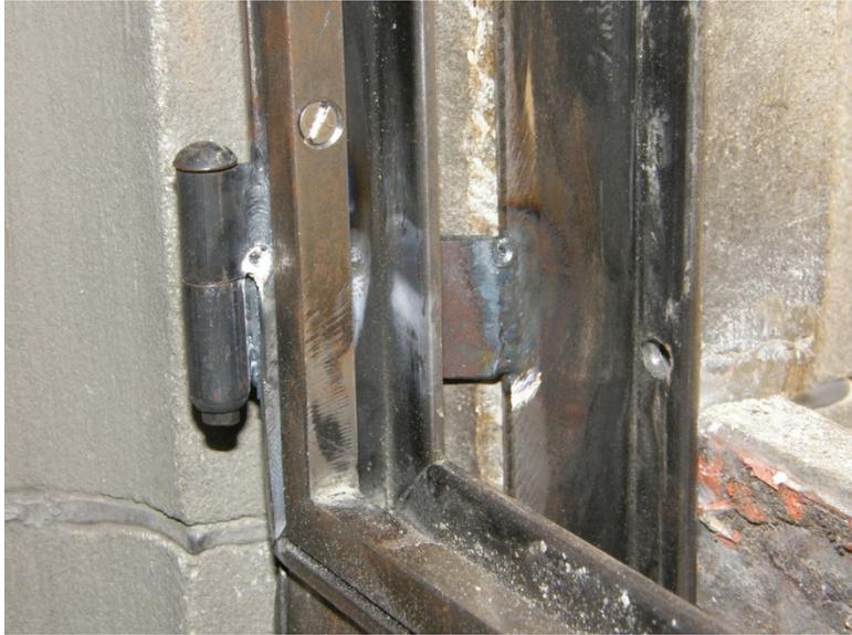
*Abb. 9: Berner Münster, Chorfenster. Neue Schutzverglasungskonstruktion (vor Einbau der Glaselemente), entwickelt nach dem Vorbild der Verglasung von 1947 durch die Münsterbauleitung (Häberli Architekten).*
