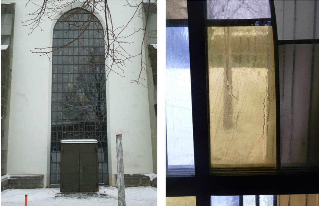
*Abb. 15: DOM-Verglasung an der Kirche St. Peter in Wil (SG). Bild links: Gesamtansicht einer Verglasung; Bild rechts: Detail derselben Verglasung mit Kondensation im Zwischenraum.*
