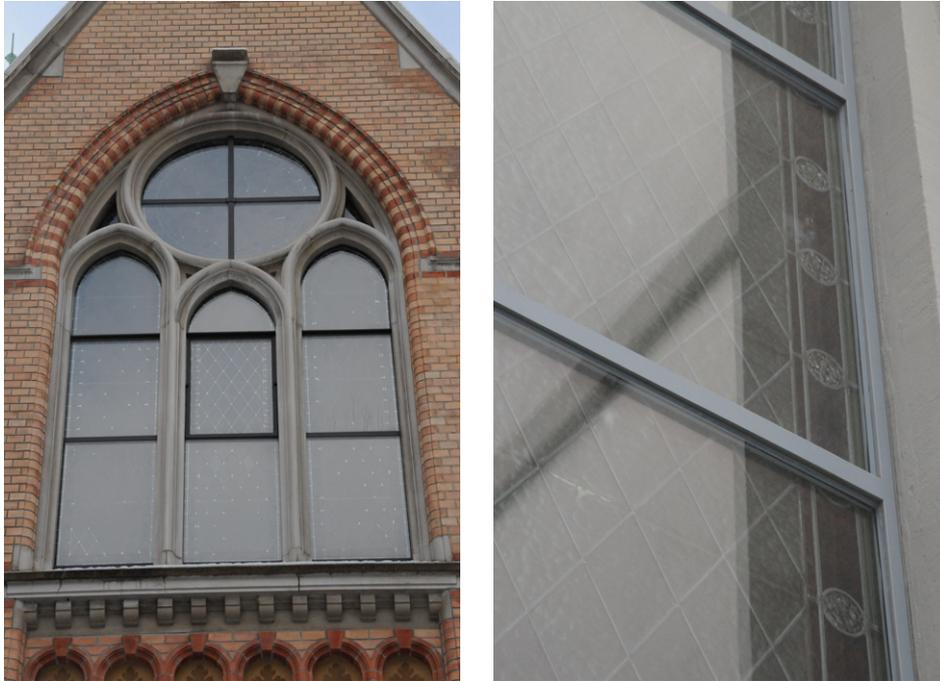
*Abb. 11: Aussenschutzverglasungen im Verbundsystem (mit Isolierverglasung). Bild links: Fenster der Bühl-Kirche in Zürich; Bild rechts: Detail eines Fensters der Ref. Kirche in Zürich-Albisrieden.*
