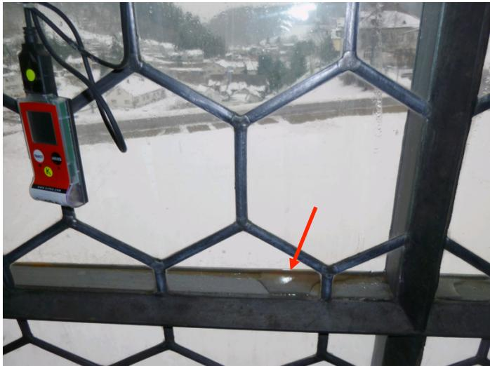
Abb. 27: Kondensat im Zwischenraum zwischen Kunst- und Schutzverglasung (roter Pfeil).
