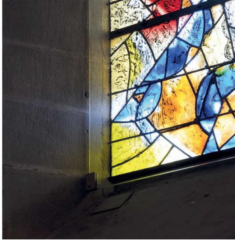
Verrière de protection intérieure, du vitrail de « Jérusalem céleste » (détail) au Fraumünster de Zurich (ZH), 1970. © Vitrail de Marc Chagall en collaboration avec Charles Marq / 2022, ProLitteris, Zürich.
