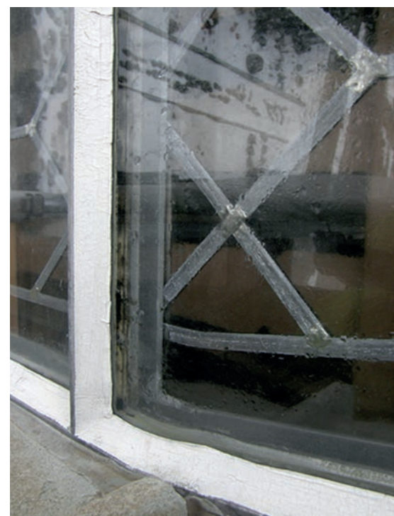
Système non ventilé avec vitrage simple dans l'église de Märwil (TG). Photo : Stefan Trümpeler, Romont.
