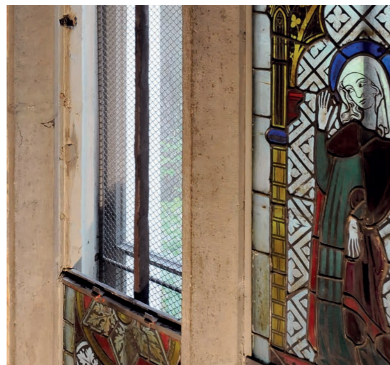
Détail de l'intérieur de la fenêtre médiévale du chœur de l'église Saint-Laurent, env. 1320. Le vitrail démonté laisse entrevoir la grille de protection et la verrière de protection externe.
