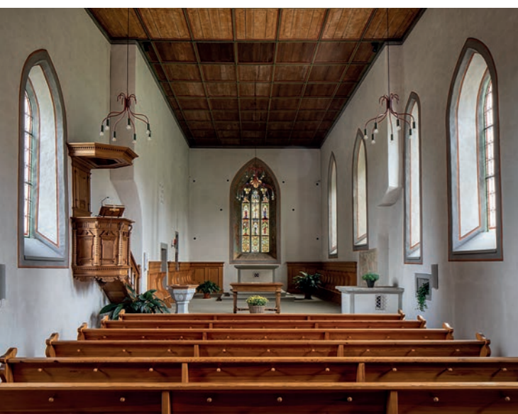
Vue intérieure de l'église Saint-Laurent de Frauenfeld-Oberkirch (TG); façade sud de l'église avec vitrage historique sans verrière de protection (en haut à droite); vue intérieure du vitrail protégé par verrière de protection (contre-fenêtre), vers 1320 (en bas à droite). Photos : Christoph Gysin, icona-basel, Bâle.
