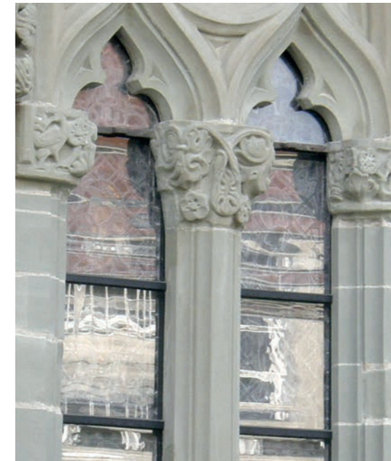
Verrière de protection avec verre soufflé en manchon de la collégiale de Romont (FR). Photo : Stefan Trümpler, Romont.
