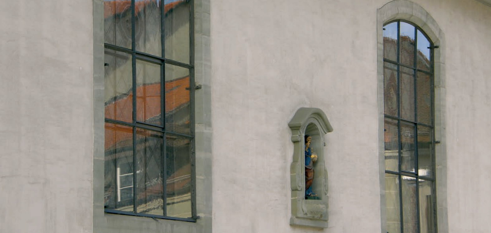
Contre-fenêtre avec cadre métallique, simple vitrage, légèrement ventilé de l'église des Capucins à Romont (FR), vers 1950.
