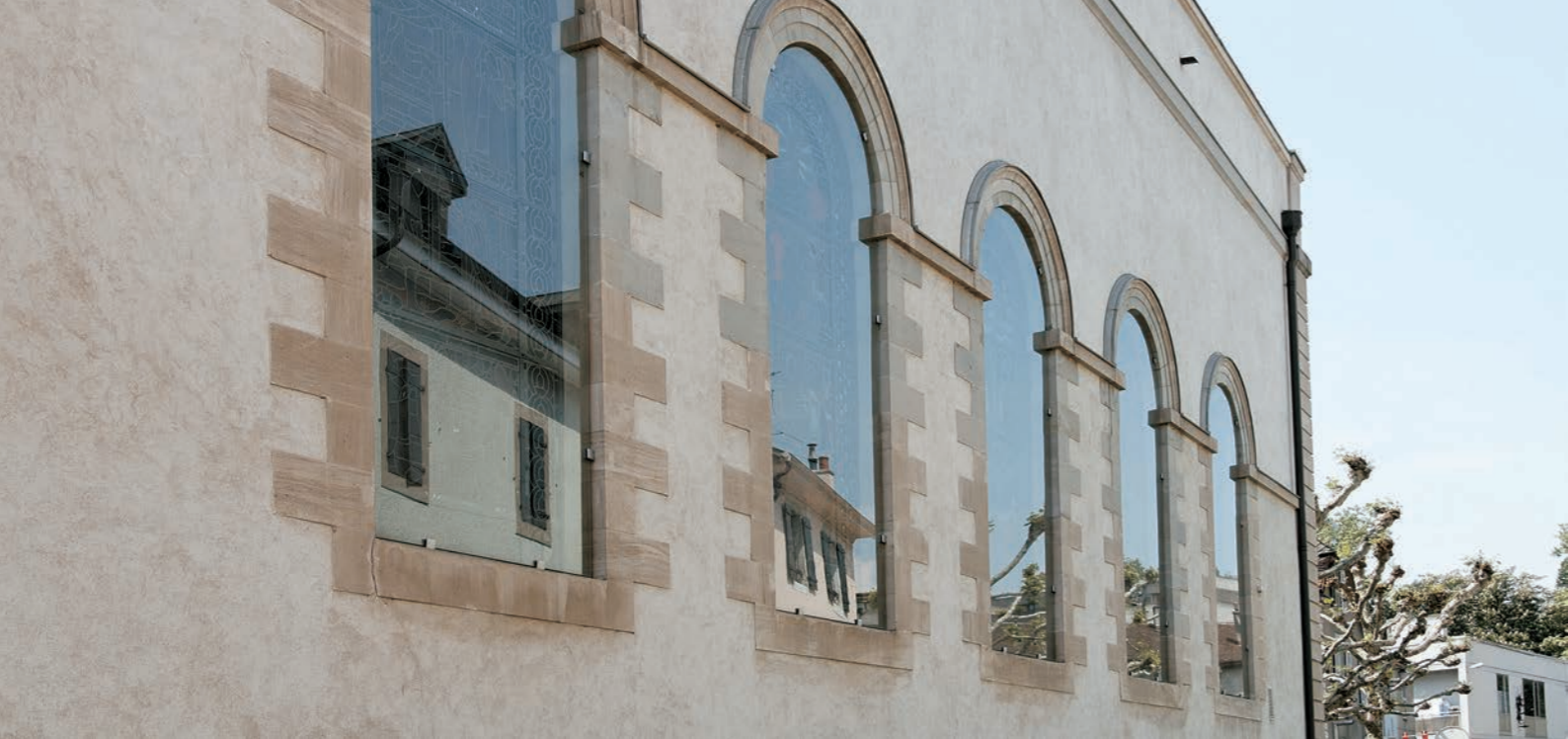
Verrière de protection sans cadre, ventilée de l'extérieur du temple de Carouge (GE). © APAS (Association pour la Promotion de l'Art Sacré), Genève. Photo : Cyrille Girardet, Veyrier.
