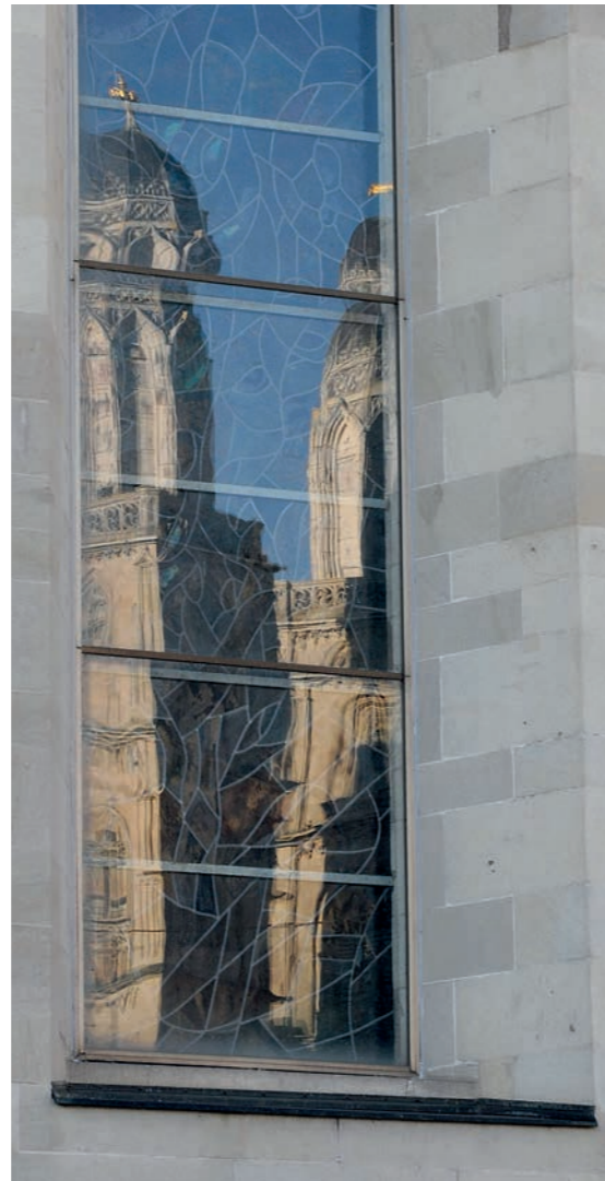
Surfaces réfléchissantes de la verrière de protection du chœur du Fraumünster de Zurich (ZH).
