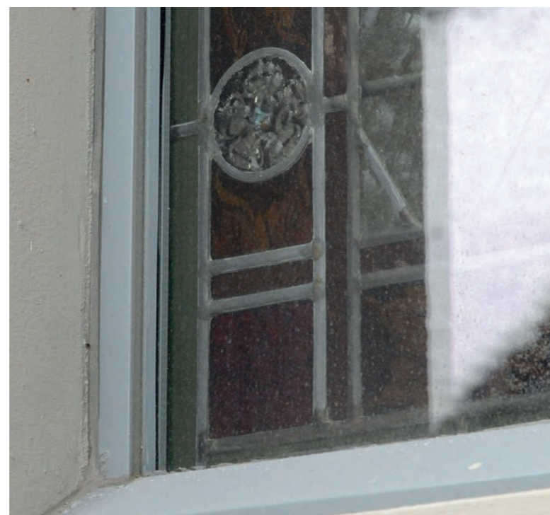
Système non ventilé avec double vitrage dans l'église d'Albisrieden, Zurich (ZH).
